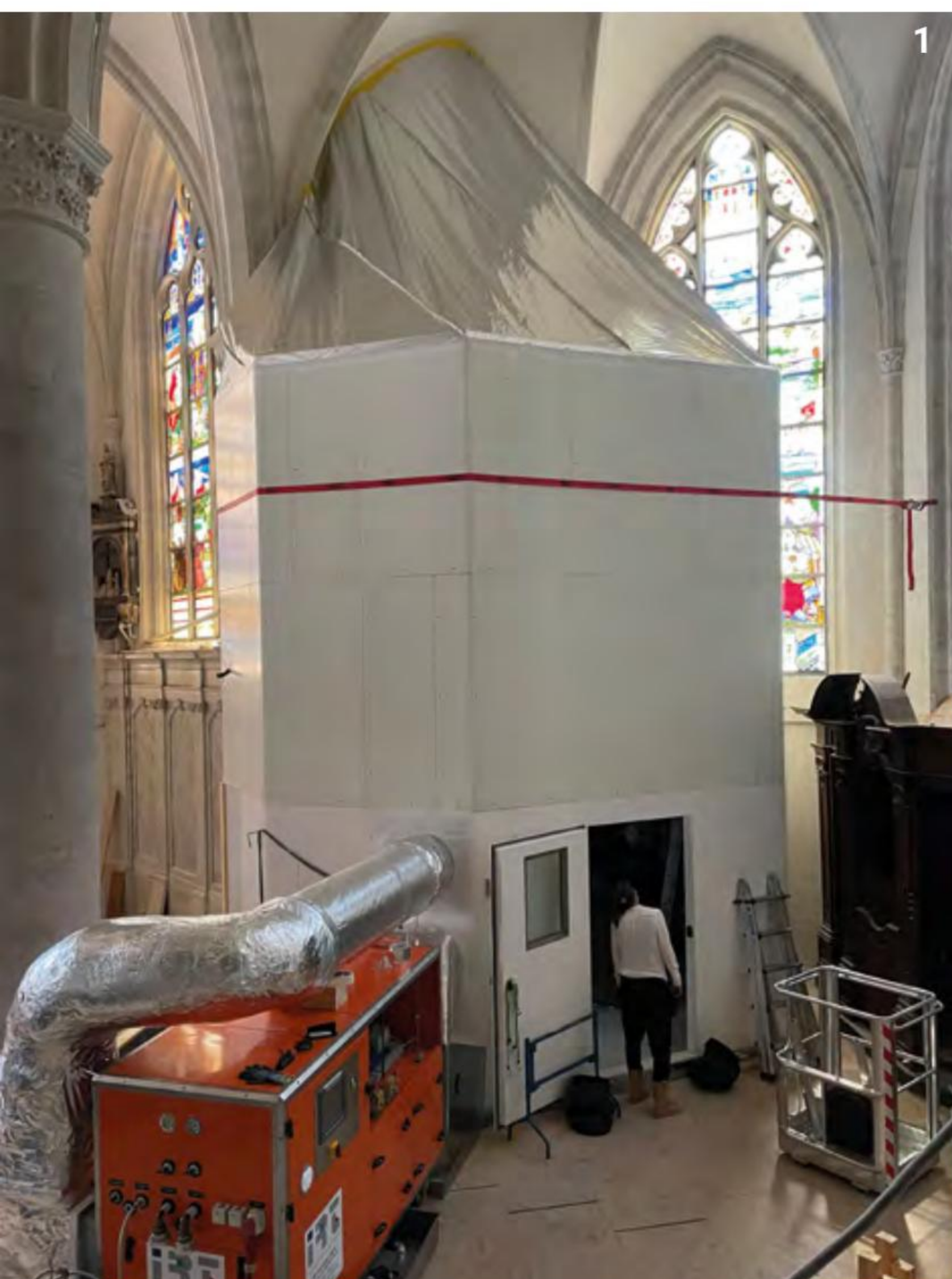
Foto 1: Warmtebehandeling van een barok- of portiekaltaar. © PERSPECTIV architecten
