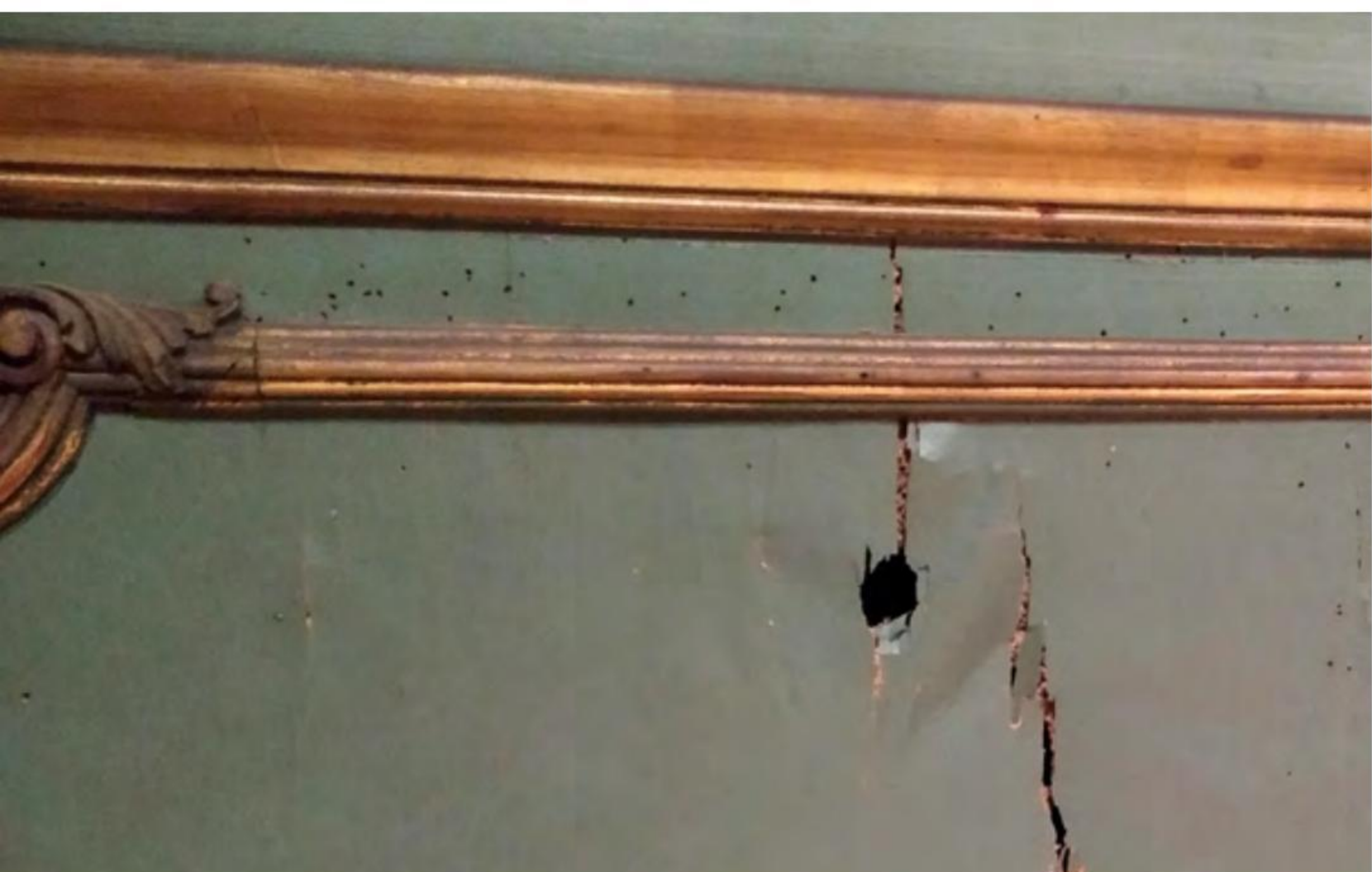
Een aangetast paneel van de lambrisering door de kleine klopkever. © stadsmuseum Lier
